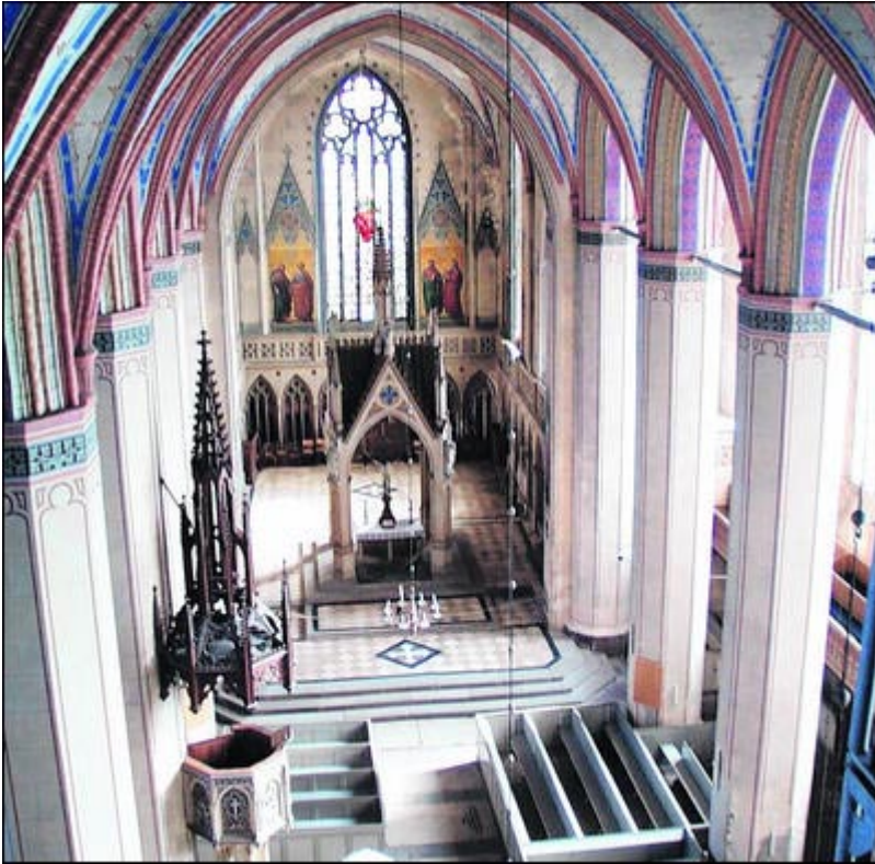
Die Barther St. Marien-Kirche muss dringend saniert werden. Der Kirchbauverein sammelt deshalb Spenden.
